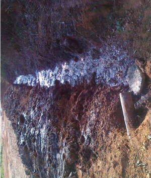
Fotografia 10: Fil·lacions d'aigua constants del dipòsit
