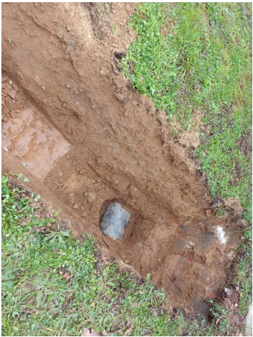
Figura 5. Connexió de la nova canonada a la canonada existent de FD DN300
